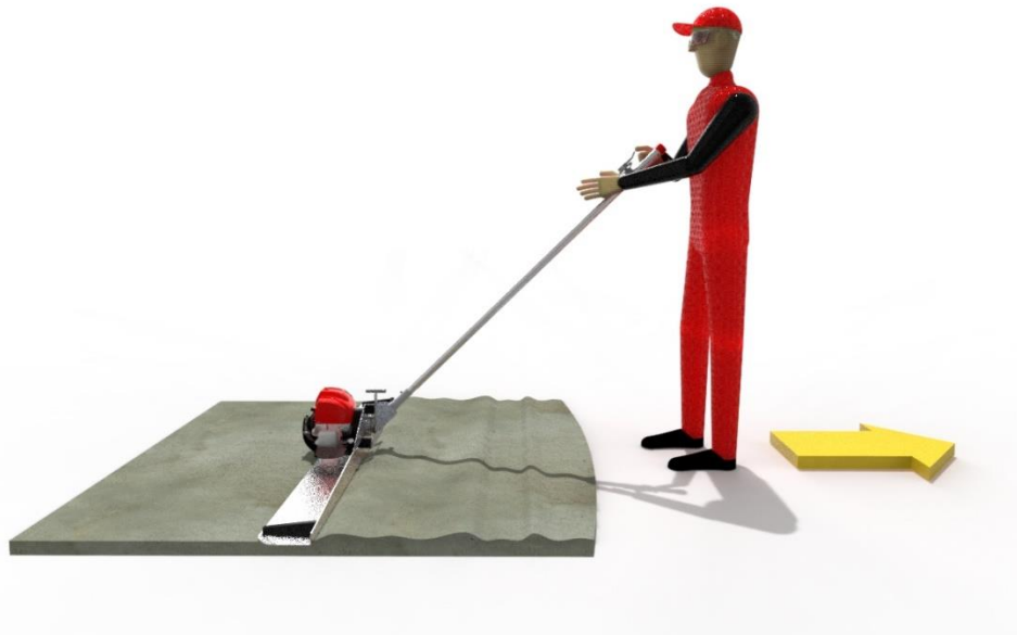
Abb. 8: Arbeiten beim Glätten und nachverdichten.
