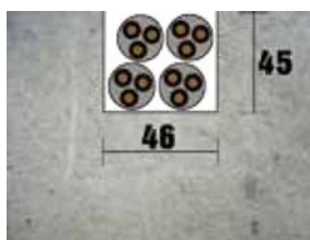
Schlitzen von Kabelkanälen
